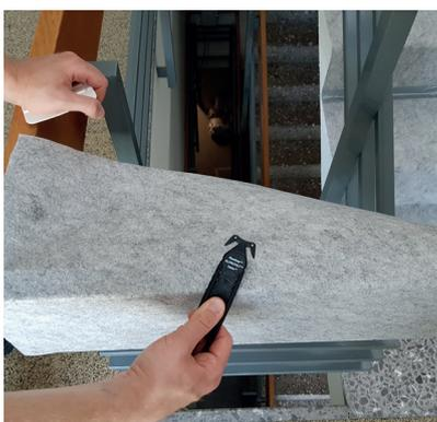
ALLPROTECT незаменим для вертикальных поверхностей, в условиях механических воздействий, и долго не теряет свойств в качестве временной защиты от грязи стандартных поверхностей и стройдеталей.
