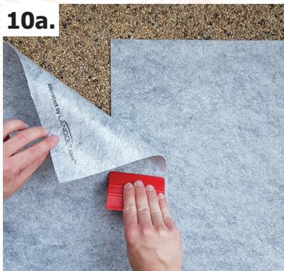
Наилучшую влагозащиту покрытие обеспечит при укладке с перехлестом 10см. На спусках, верхнее полотно кладите поверх нижнего.
