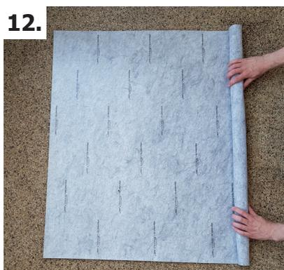
Снимая ALLPROTECT для повторного использования скатывайте его рулонами клейкой стороной внутрь.
