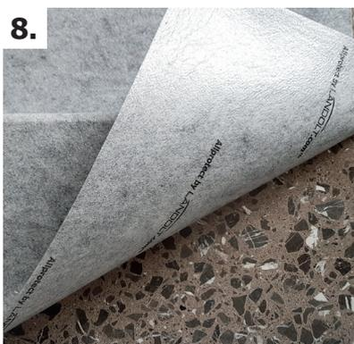
Рекомендуется предварительно тестировать прилипание на каждом типе поверхности. Укладывайте покрытие липким полиэтиленом вниз. Направление - любое.
